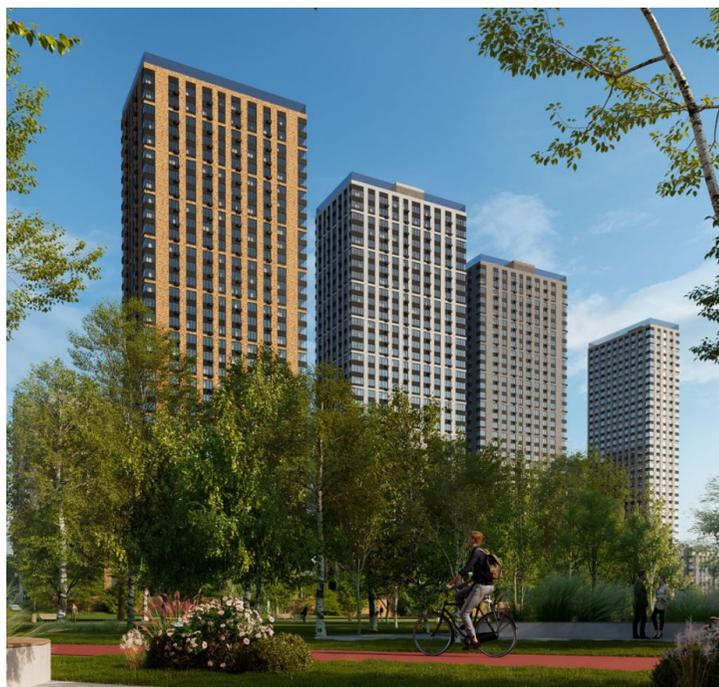
Жилой комплекс «Фестиваль Парк» состоит из двух частей – 31-этажной башни и трех удаленных от нее на 500 метров 30-35-этажных корпусов с единым двухуровневым стилобатом. Здания строятся по современной монолитной технологии, снабжены вентилируемыми фасадами и декорированы керамогранитом. Цветовая гамма фасадных элементов предусматривает сочетание двух натуральных оттенков: бежевого и коричневого.
