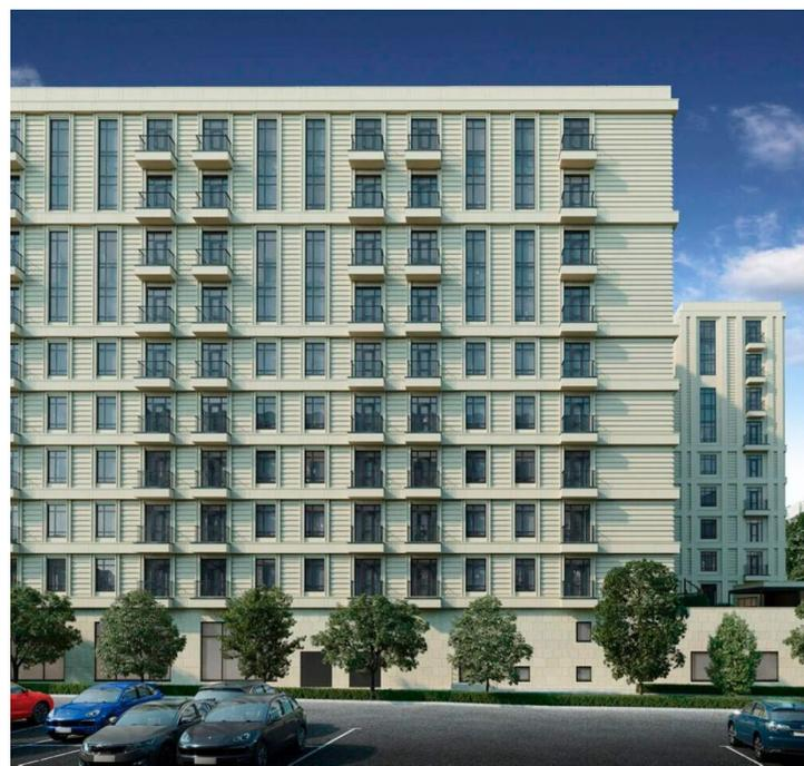
Апарт-комплекс «Королева, 13» включает в себя 1 корпус высотой в 10 этажей. Здание возведено по долговечной кирпично-монолитной технологии. Стены облицованы современным навесным вентилируемым фасадом.
