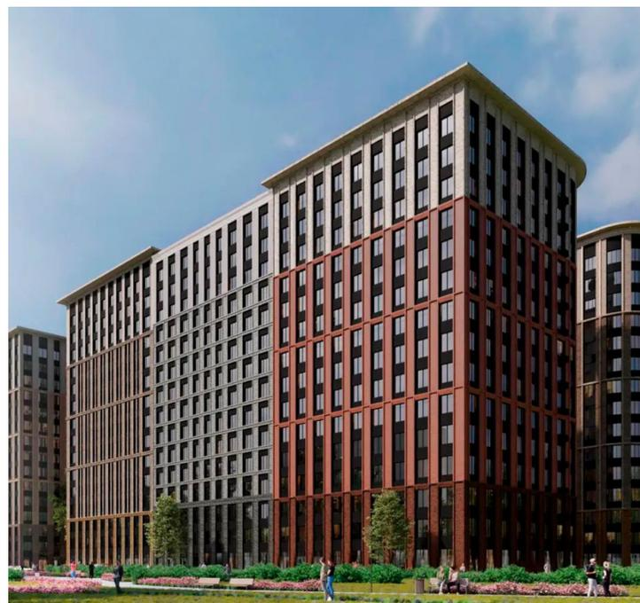
«Апарт-комплекс Движение. Говорово» — это 2 корпуса высотой в 15 этажей. На современных индивидуальных фасадах зданий применены разнообразные архитектурные приемы пластики и цветовое сочетание. В качестве материалов применяются декоративная бетонная плитка «под кирпич» и вставки из алюмокомпозита между окнами для визуального объединения и увеличения габаритов окон и формирования сетки фасада.
