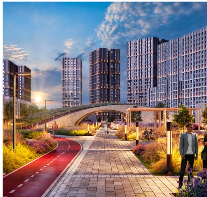
Жилой комплекс «Квартал Румянцево» состоит из 4 корпусов переменной этажности. Дома построены по долговечной кирпично-монолитной технологии. В оформлении стен зданий используется современный навесной вентилируемый фасад. Входные группы с высокими потолками и просторными холлами отличает индивидуальный дизайн. Помещения отделаны и декорированы экологически чистыми материалами природных оттенков.
