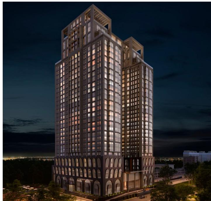
Проект «Поклонная 9» — это 32-этажное здание в стиле московских высоток и небоскребов Нью-Йорка. Дом построен по долговечной кирпично-монолитной технологии. Стены здания облицованы навесным вентилируемым фасадом из керамогранита. Концепция проекта предполагает размещение на нижних этажах 5-звездочного отеля международного уровня.
